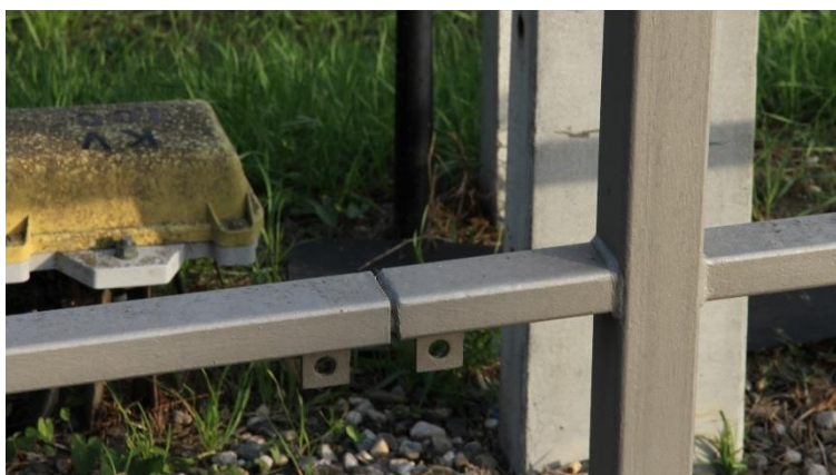
Abb. 6-5 Geländer ohne Längsverbindung, jedoch mit hierfür vorgesehenen Laschen (Foto: Wittemann)
