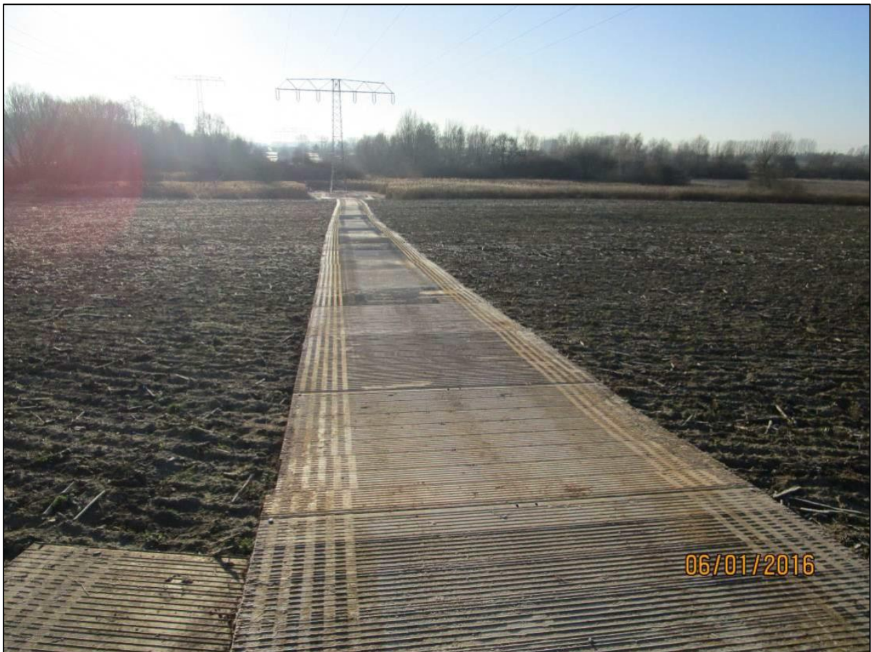
Abbildung 11: Beispiel einer Baustraße mit Matten
