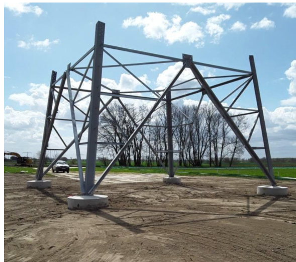
Abbildung 4: Beispiel eines wiederverfüllten Plattenfundamentes
