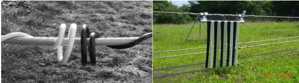
Abbildung 9: Beispiele für Vogelschutzmarker (links: Spiralmarker, rechts: Klappmarker)
