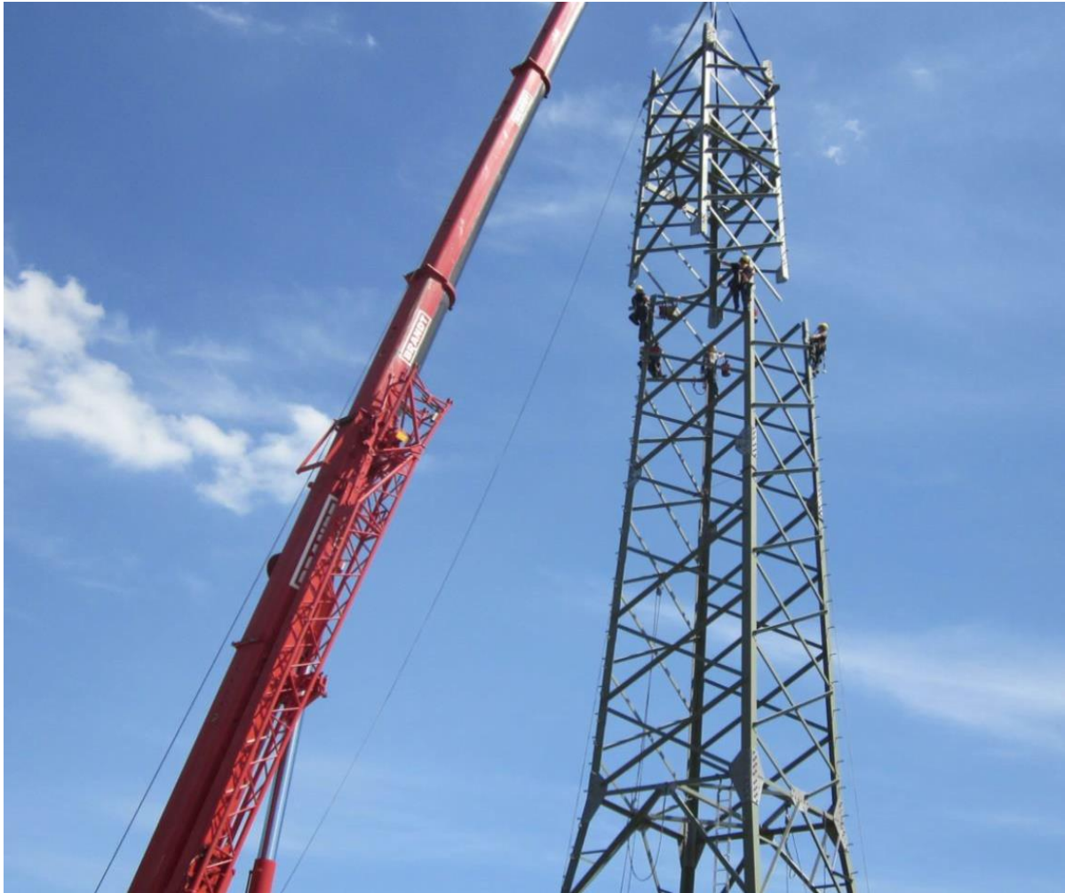
Abbildung 14: Maststocken mittels Autokrans
