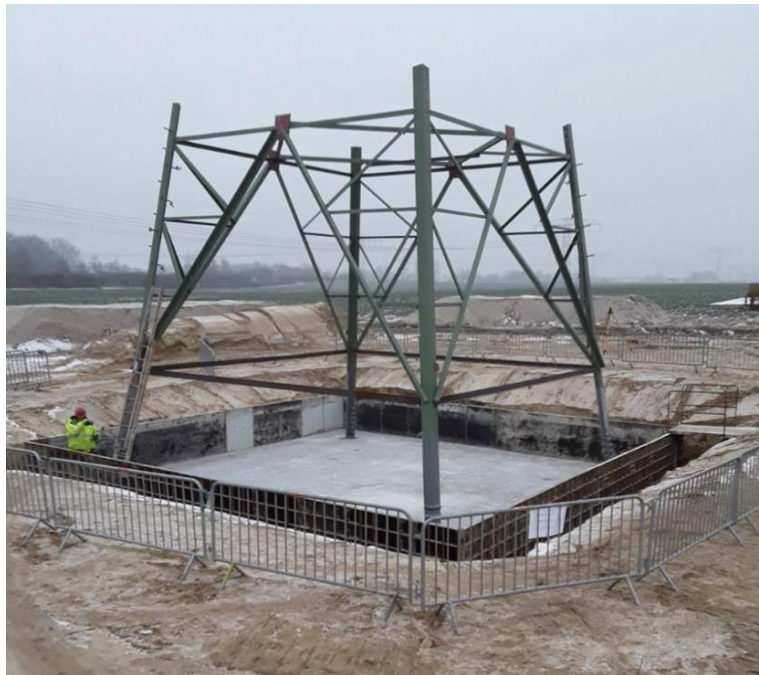
Abbildung 12: Baugrube mit Fundament (ohne Fundamentköpfe)
