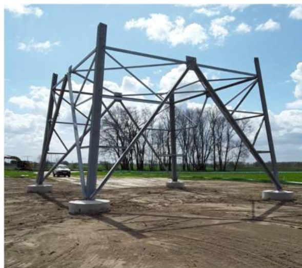
Abbildung 5: Beispiel eines wiederverfüllten Fundamentes
