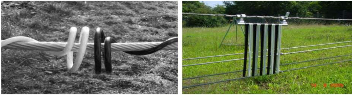
Abbildung 8: Beispiele für Vogelschutzmarker (links: Spiralmarker, rechts: Klappmarker)
