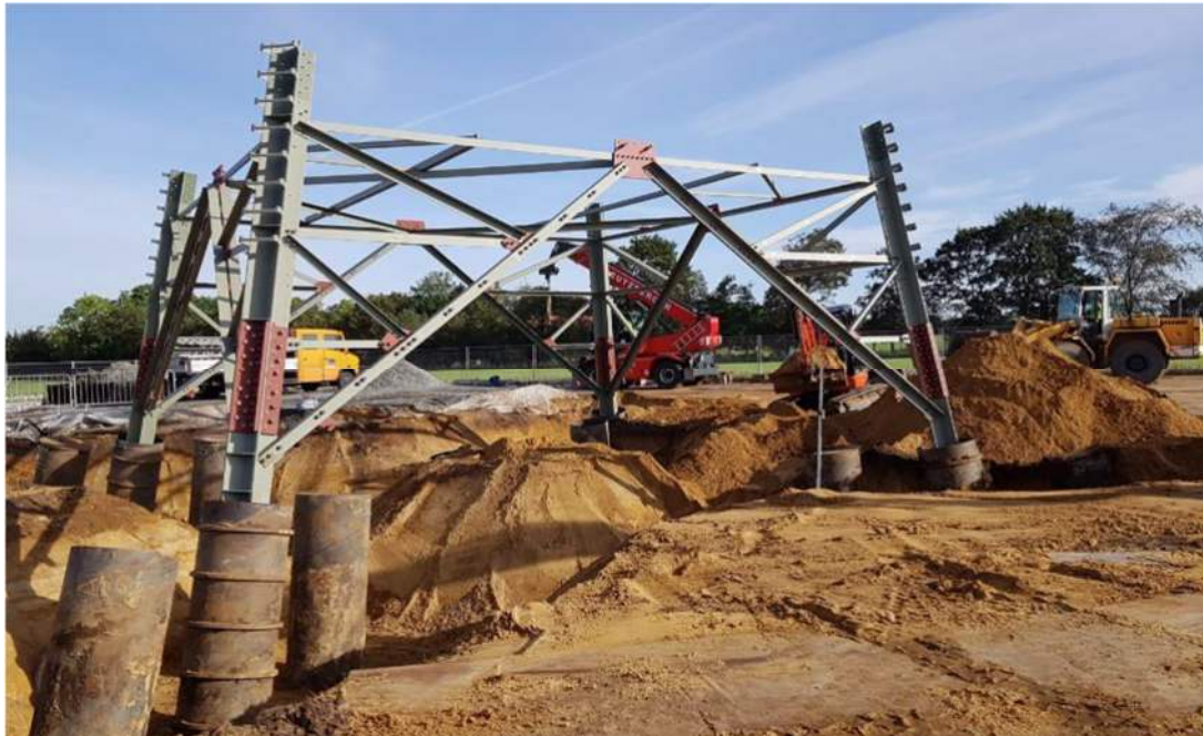
Abbildung 11: Rammfundamente (Ausführung als Bündelpfähle)
