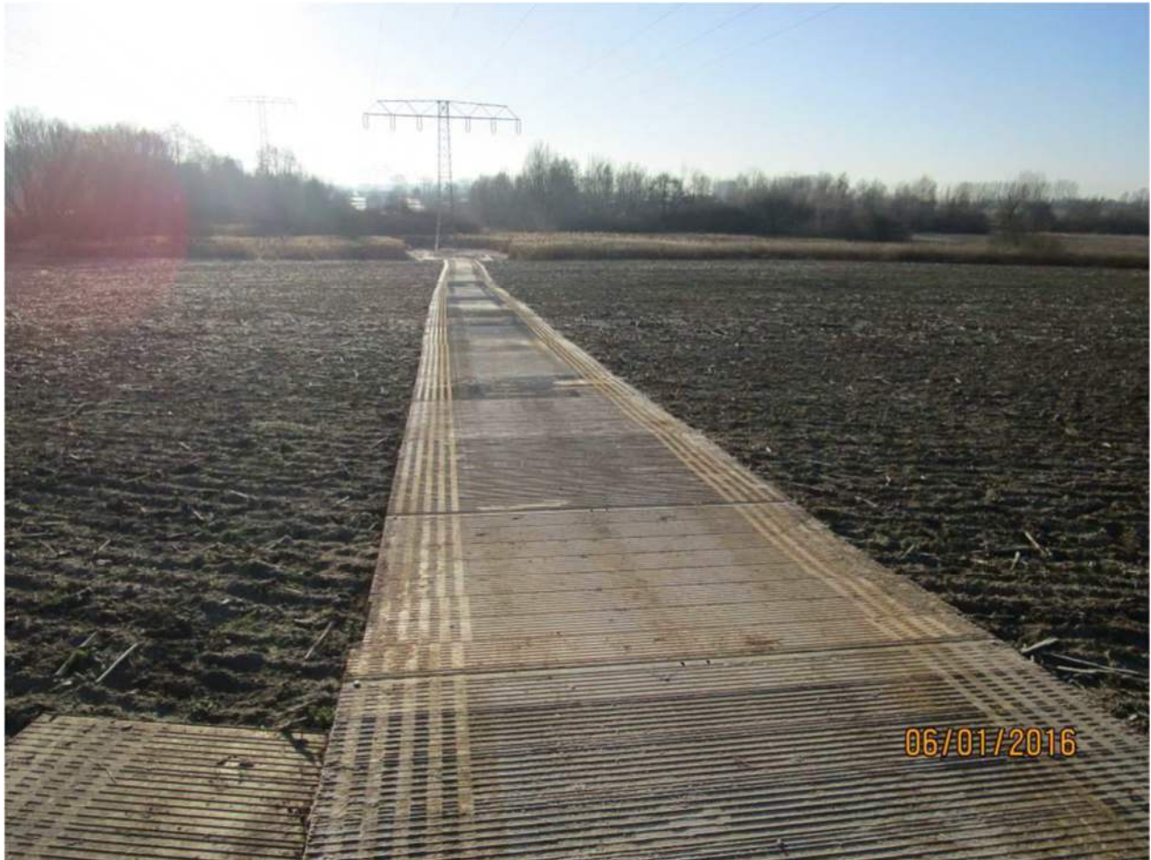
Abbildung 10: Beispiel einer Baustraße mit Matten
