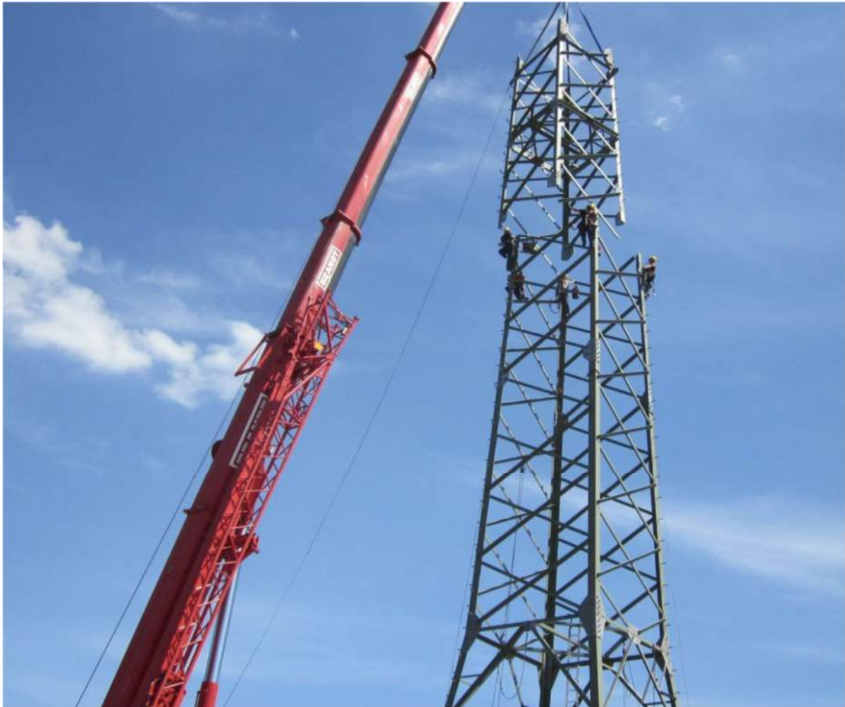
Abbildung 12: Maststocken mittels Autokran
