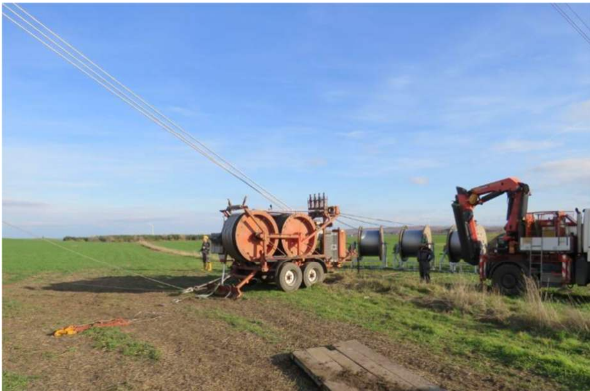
Abbildung 13: Aufstellplatz für Seiltrommel
